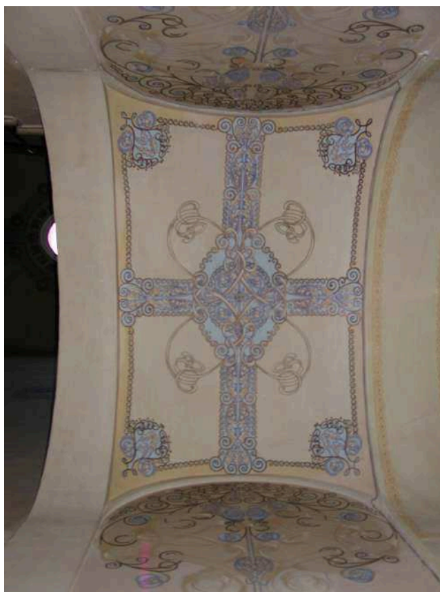
Figura 1 Soffitto libreria ingresso piano terra
