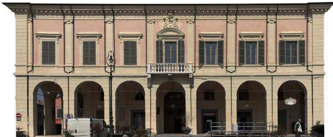
Palazzo Comunale dopo l'intervento
