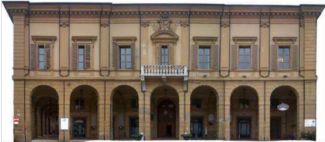
Palazzo Comunale prima dei lavori
